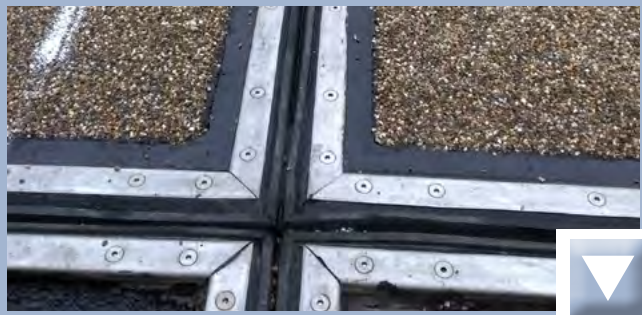
Vormen en uitvoeringen van dilatatievoegprofielen
